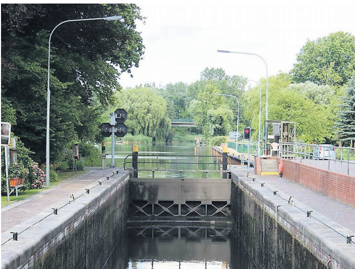
In die 55,00 Meter lange und 6,50 Meter breite Kammer der Schleuse Lübz würden sogar Saalemaßkähne passen. Der Schleusenhub beträgt hier 3,20 Meter.
