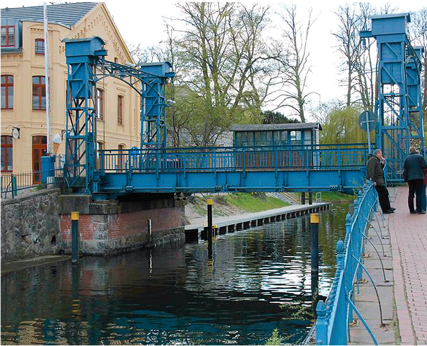
Die Stahlkonstruktion der Hubbrücke in Plau war ursprünglich dunkelrot gestrichen. Seit den 1950er Jahren erstrahlt sie in verschiedenen Blau-Tönen. Fotos: Sven Bardua
